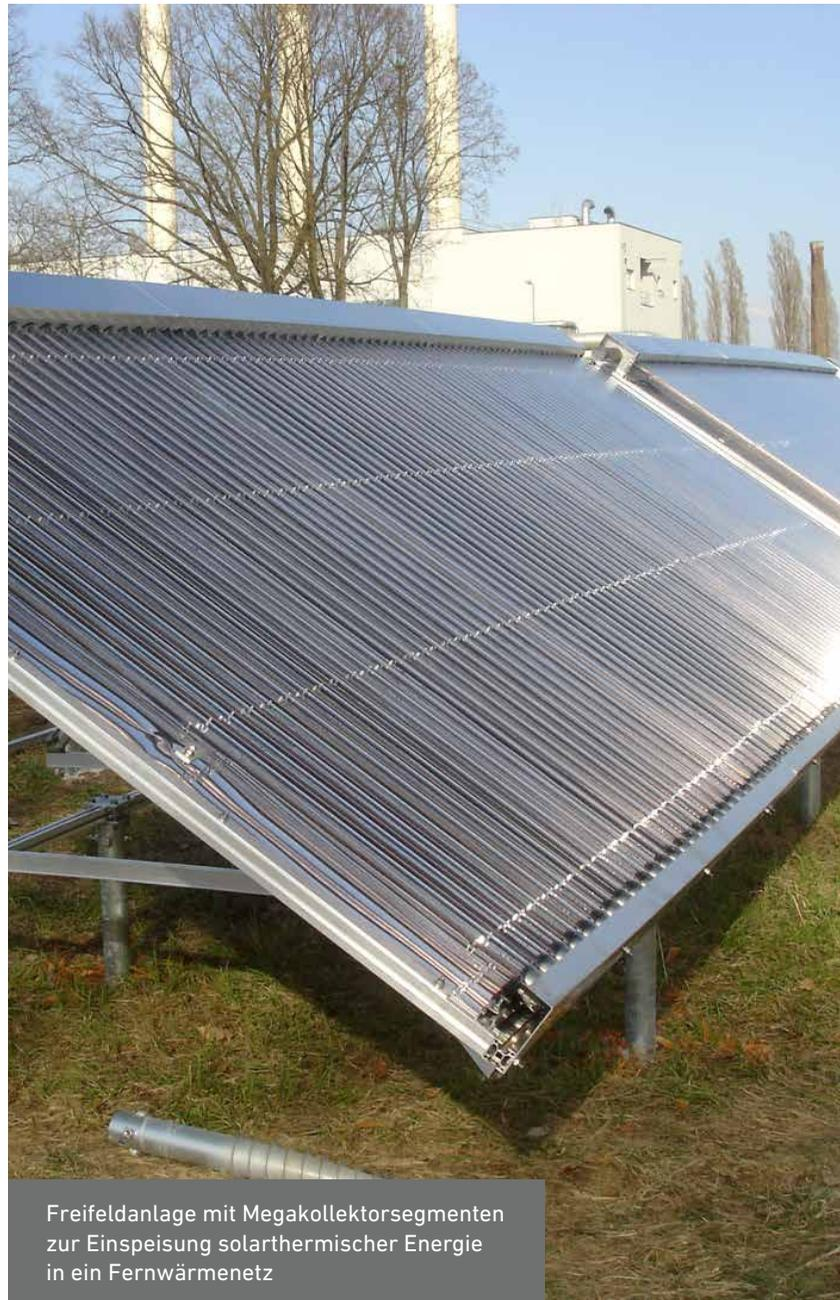
Freifieldanlage mit Megakollektorsegmenten zur Einspeisung solarthermischer Energie in ein Fernwärmenetz
