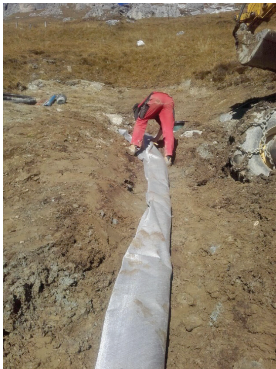
Verlegen der Ableitung zum Quellschacht
