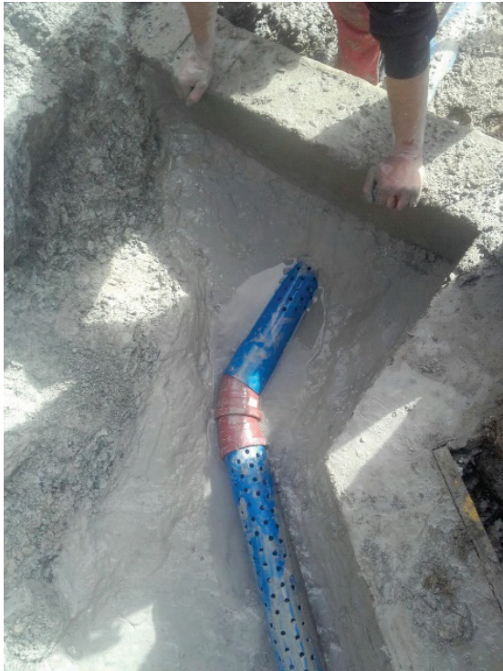
Untere Abdichtung mit Lehm
