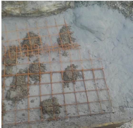
Stahleinlage für Betondeckel
