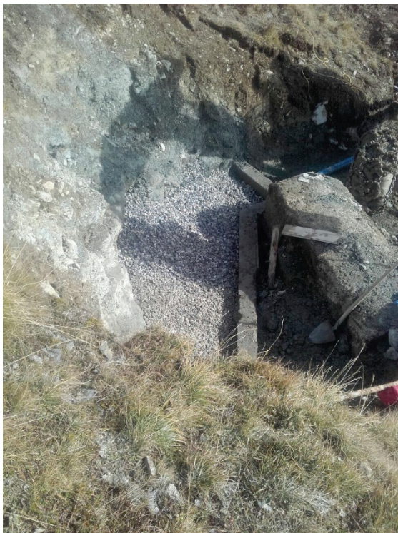
Einbringen des Drainagekieses
