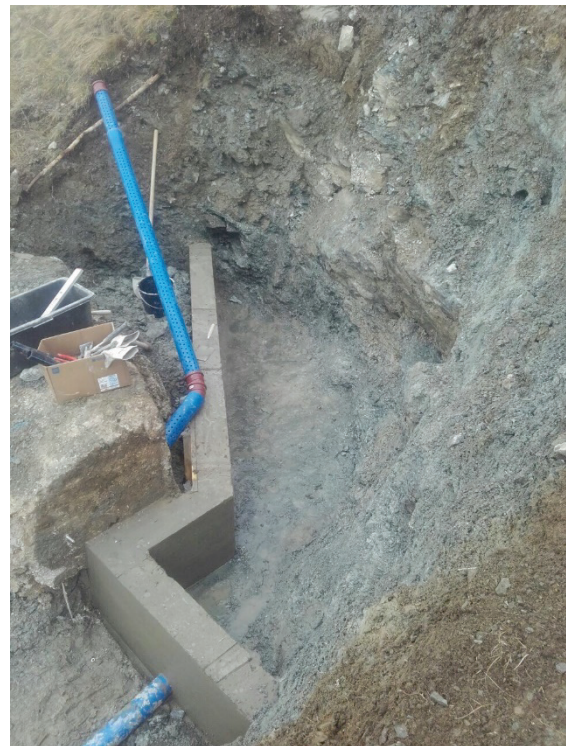
Betonriegel ausgeschalt
