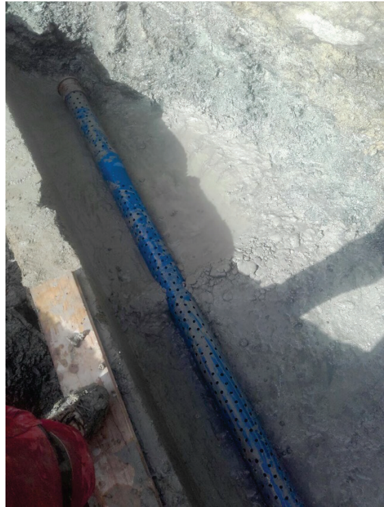
Verlegen des Sickerrohes
