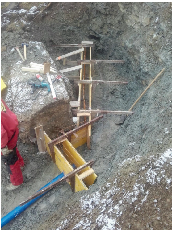
Schalen des Betonriegels
