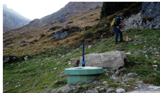
fertiger Quellschacht
