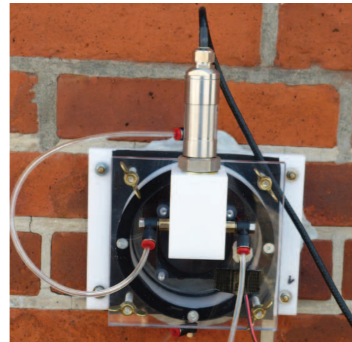
Anbringung des zerstörungsfreien Messverfahrens an einem gut saugenden Ziegelmaterial.
