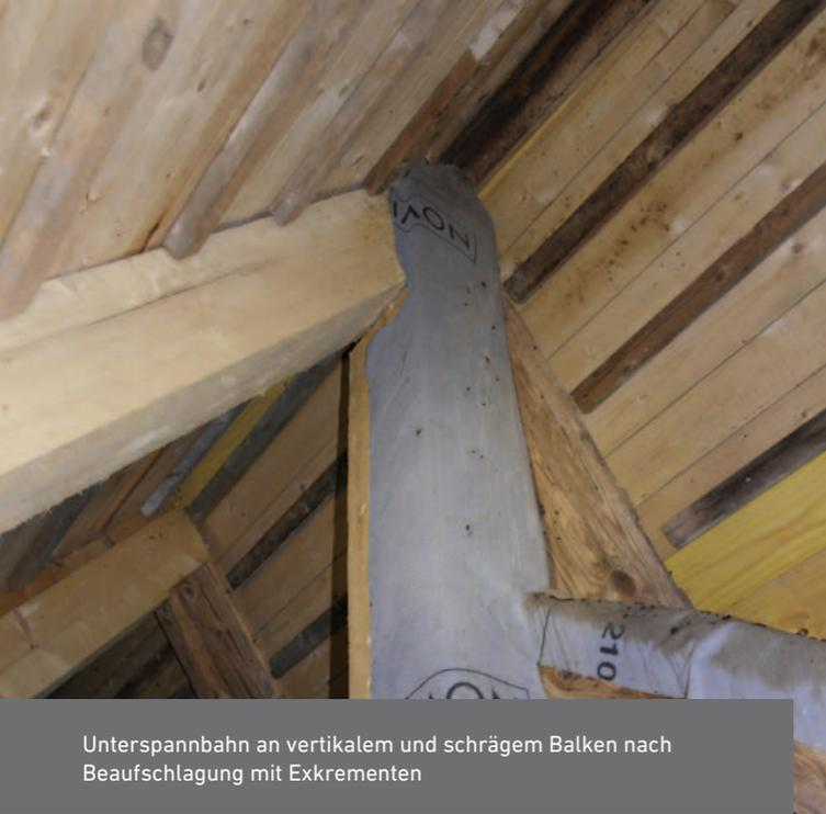
Unterspannbahn an vertikalem und schrägem Balken nach Beaufschlagung mit Exkrementen
