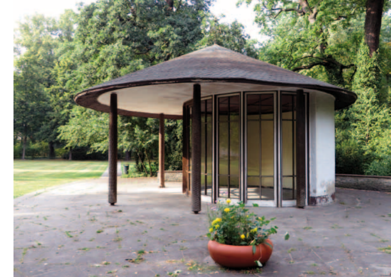
Pavillon mit zierlichen Säulen und halboffenen Charakter
