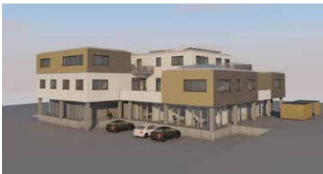
Die Sparkasse Kressbronn nach der Sanierung und mit aufgestockten Energiewendemodulen
