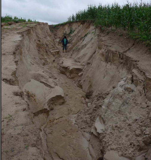
Erosionsgraben auf einer Linienbaustraße © Ingenieurbüro Feldwisch
